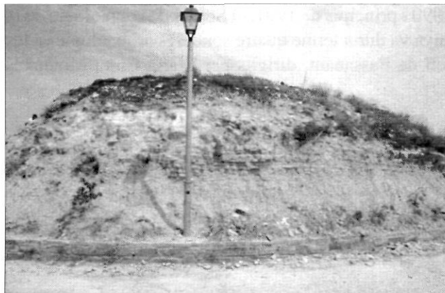
Vistes dels talussos del castell abans de la intervenció.
