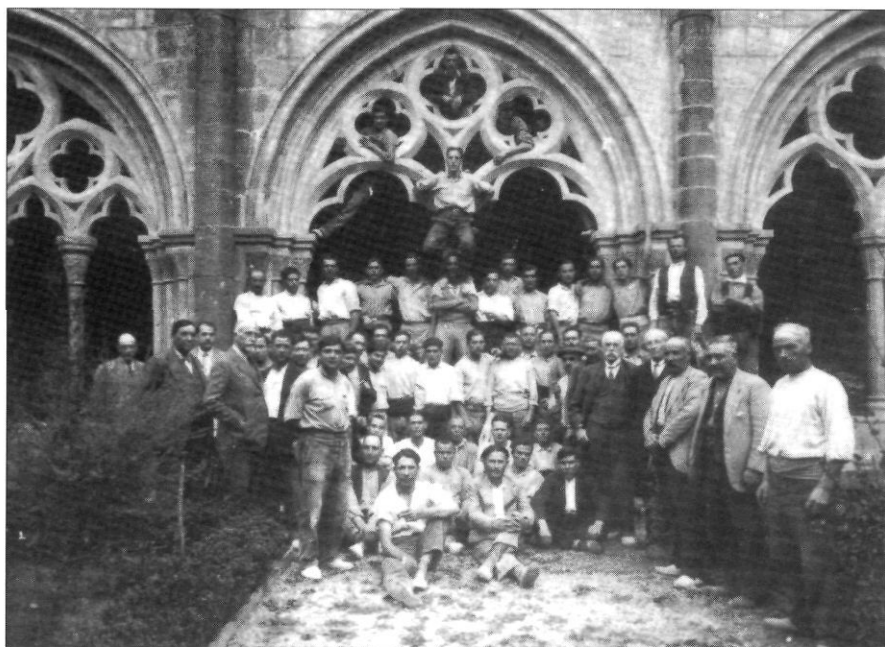
Eduard Toda, amb els treballadors en la restauració de Poblet, pels volts del 1932. S'hi distingeixen també Cosme Oliva i Lluís Plandiura, entre d'altres. (Col·lecció privada de l'Espluga de Francolí)
