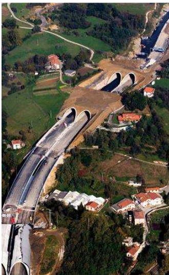
Figura 89.- Y Vasca: Tren de Alta Velocidad (TAV) “En Construcción” .
