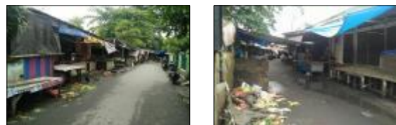
Gambar 4.7 Kondisi Pasar Tradisional Bobo
