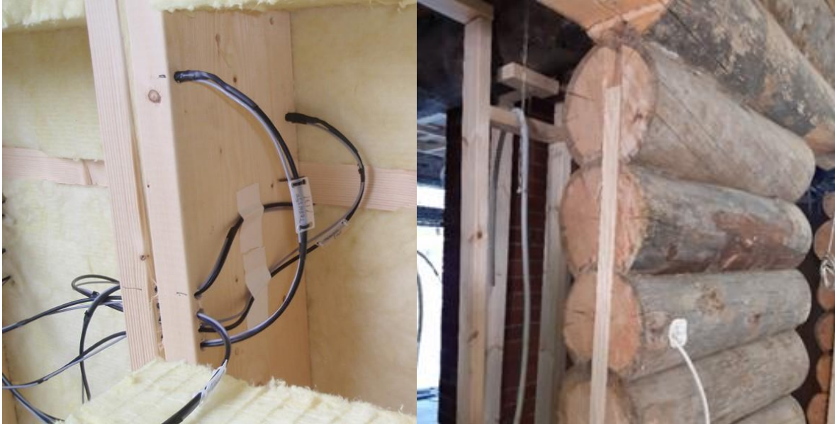
Kuva 5. Puumateriaalin ominaisuudet poikkeavat monessa kohtaa homogeenisempien materiaalien ominaisuuksista, joka on syytä ottaa mallintamisessa huomioon. Vasemmalla rakennemittausanturit seinäelementissä (Kuva, Mika Palosaari), oikealla hirsirakennuksen oviaukko (Kuva, Tiina Vainio-Kaila).
