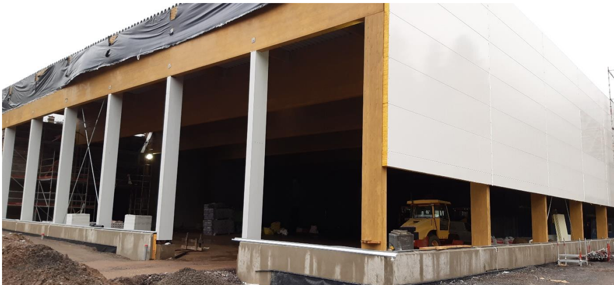
Kuva 4. Pirkkolan uudessa jäähallissa on massiivipuiset rakenteet yhdistettyinä muihin materiaaleihin, kuten betoniin ja sandwich-paneeliin.
