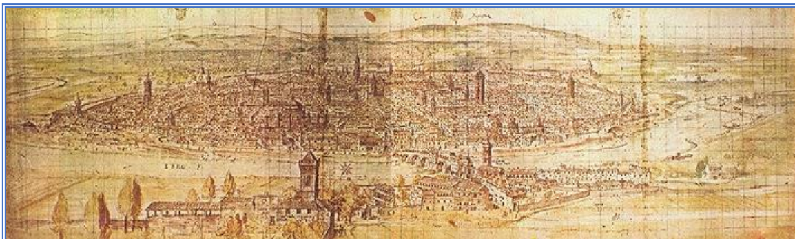
92. Vista de Zaragoza de 1563 2630,2631 .
