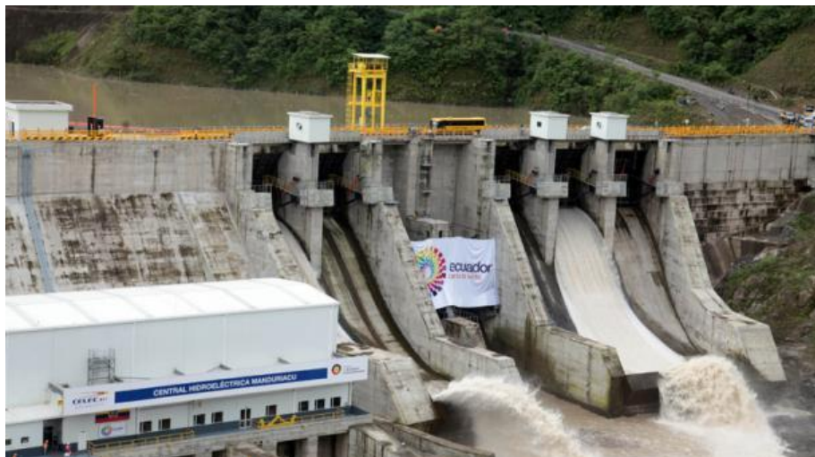
Gráfico 7. Central hidroeléctrica con presa de hormigón compactado.
