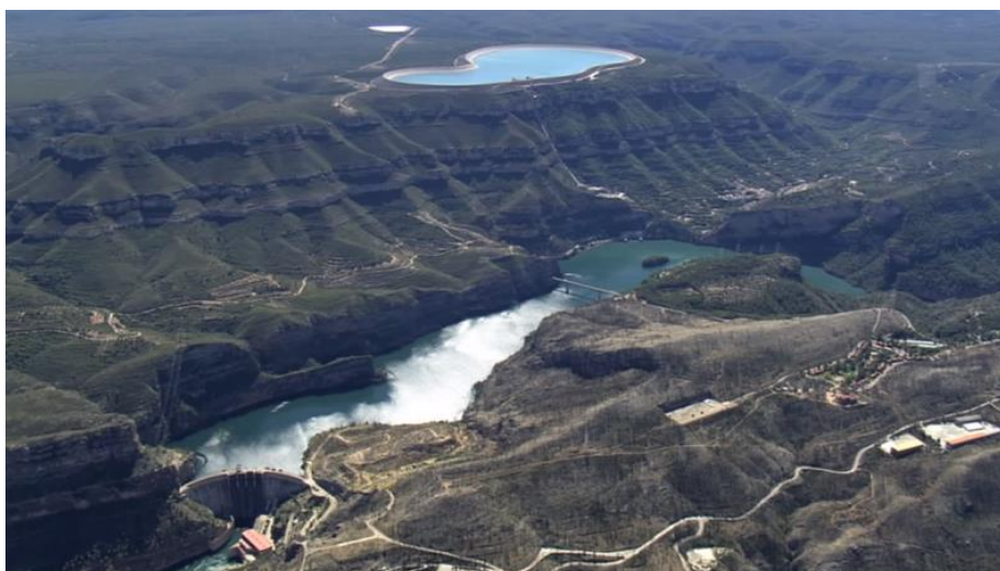
Gráfico 8. Central hidroeléctrica de bombeo con dos embalses.
