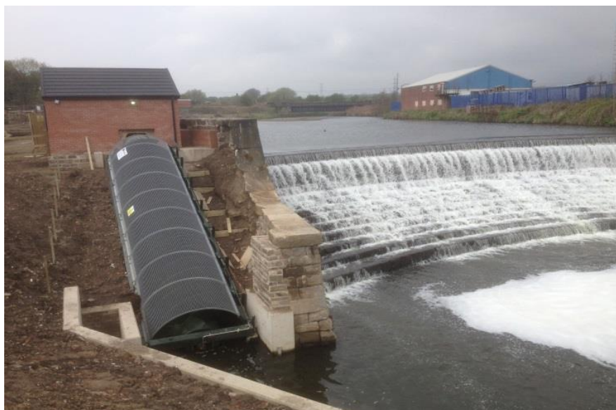
Gráfico 10. Central hidroeléctrica de agua fluvente con interposición Fuente: (EcoEvolution, 2013)
