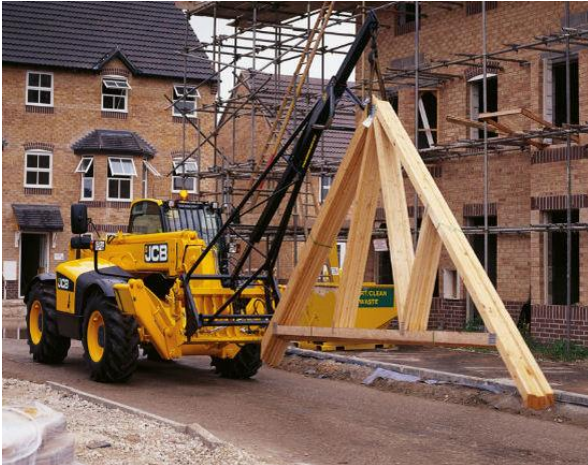
Figura 39: Empleo del extensor grúa. Fuente: JCB. (n.d.). Telescopic Handler Attachments Guide Construction & Industrial. Retrieved from www.jcb.com
