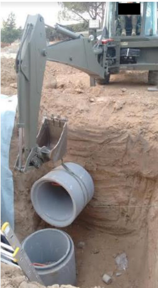
Figura 42: Método expedito de colocación de elemento prefabricado. Fuente: elaboración propia.
