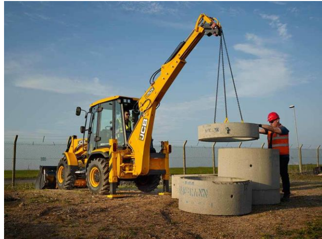
Figura 35: Izado de tubo prefabricado de hormigón. Fuente: www.jcb.es
