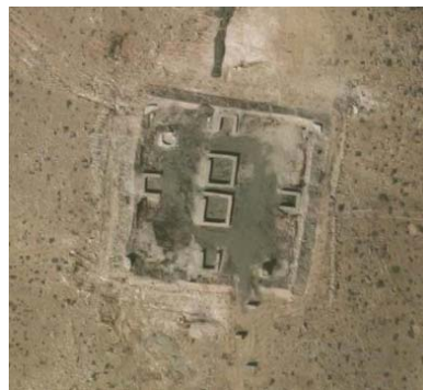
Figura 64.- Fotografía aérea de la posición de combate avanzada. Fuente: Google maps
