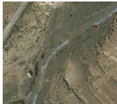
Figura 65.- Fotografía aérea del campo de explosivos. Fuente: Google maps
