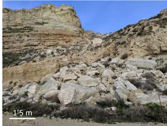
Figura 7.- Depósito de rocas en la base del escarpe Remolinos-Alfocea. Localizado en el “Camino de Torres de Berrellén a El Castellar”. Bloques pertenecientes al deslizamiento 7, concretamente a los paquetes PVI y PVII. Coordenadas sexagesimales: 41°46’53’’N 1°03’27’’W. Altitud: 252 m. Fotografía tomada en campo.
