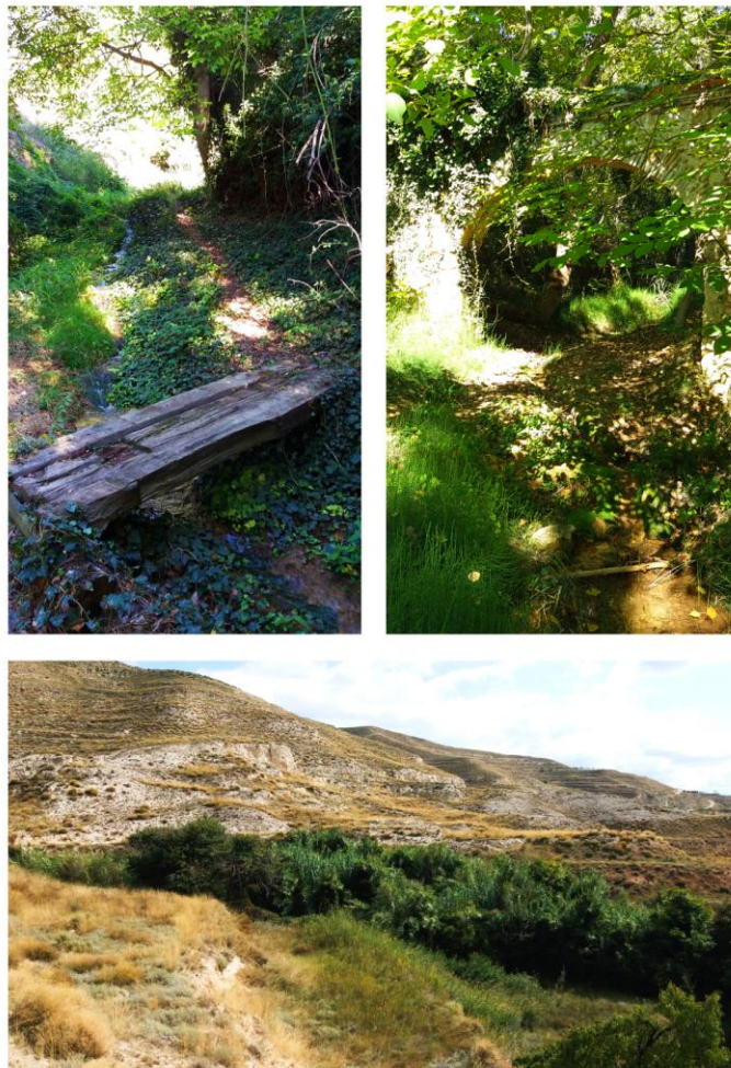
Figura 6: Fotografías del arroyo “Los vales”, situado entre las localidades de Montón y Villafeliche. Estos barrancos se caracterizan en su tramo bajo por tener poca anchura y estar encarrilado entre paredes verticales.
