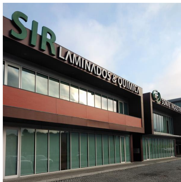
Figura 1- Instalações da SIR na Maia
