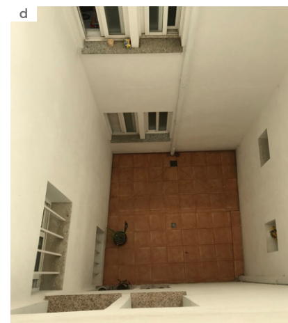
Fig.[01] a. e b. Vista exterior do Edifício N°3/5 da Rua Cova da Serpe; c. Caixa de escadas do edifício d. Pátio de luz
