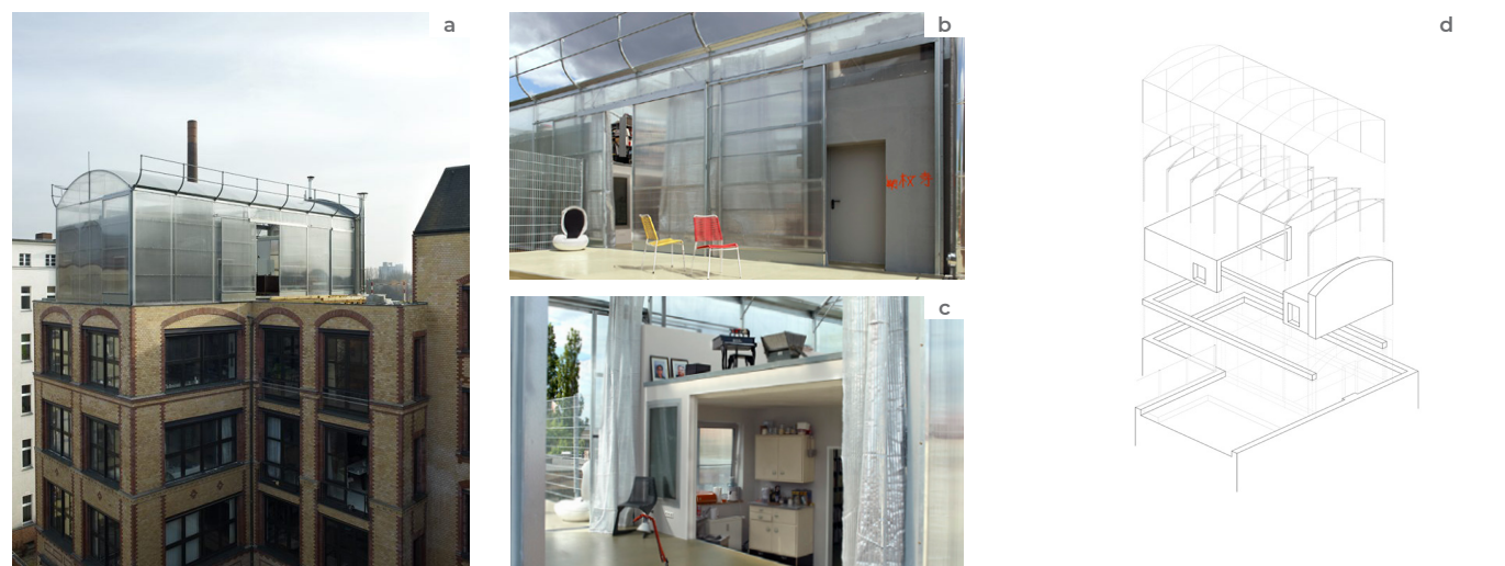
Fig.[08] Christof Mayer e Martin Heberle - Green House a. e b. Vista exterior; c. Perspetiva interior; d. Representação axonométrica da adição
