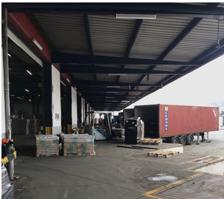
Figura 8 - Corredor entre os cais e as portas
