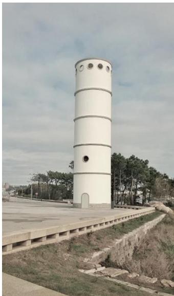
Figura 20 Imagem obtida por parte da galeria de fotos (fonte: google earth, autor Rui Silva)
