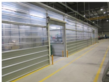
Figura 25 - Ambiente isolado onde se encontra a Soldadura e a Decapagem.
