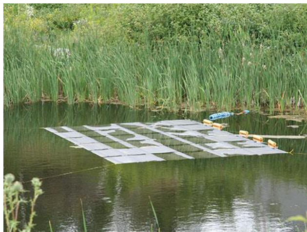
Figura 2.12. Painéis sem estrutura flutuante [adaptado de Sudbury (2013)]
