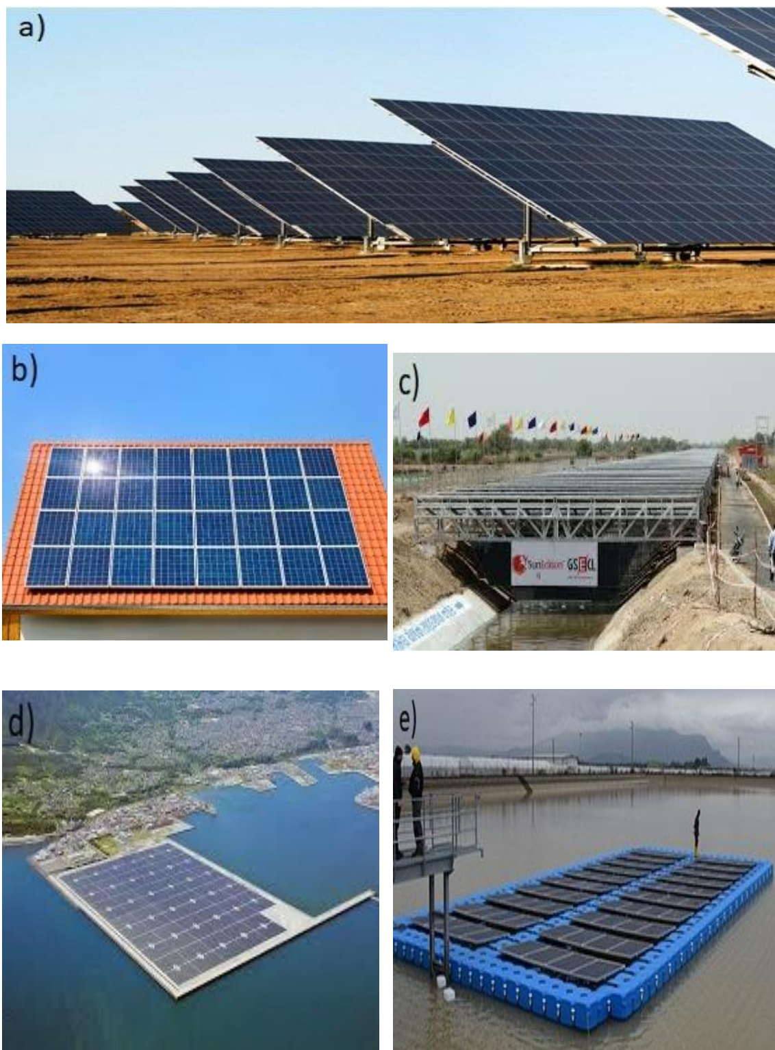
Figura 2.3 - Diferentes instalações de painéis fotovoltaicos, a) apoiados no solo, b) telhado, c) sobre canal de água, d) na costa, e) sistema flutuante.
