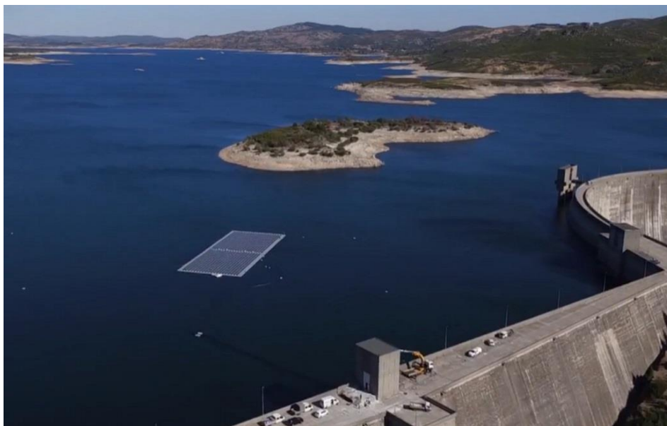
Figura 1.3 - Estrutura flutuante com painéis fotovoltaicos na albufeira da barragem do Alto Rabagão [adaptado de Diário de Trás-os-Montes]
