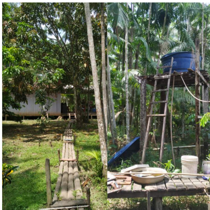
Figura 25 – Caixa de água localizada no quintal de um dos moradores da APA (Autora, 2019).
