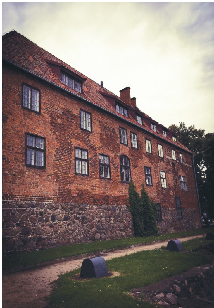
Rycina 2. Zamek prokuratora krzyżackiego w Kętrzynie; stan obecny (fot. autor).
