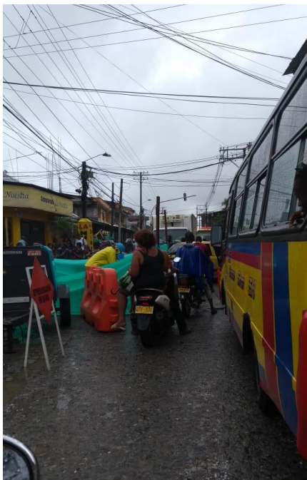
Ilustración 11 Tráfico multimodal y obra en la vía.
