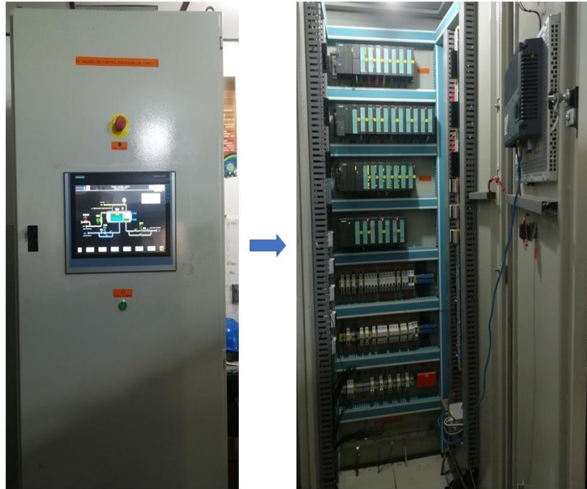
Figura 33. Montaje real de PLC en gabinete para sala de control.
