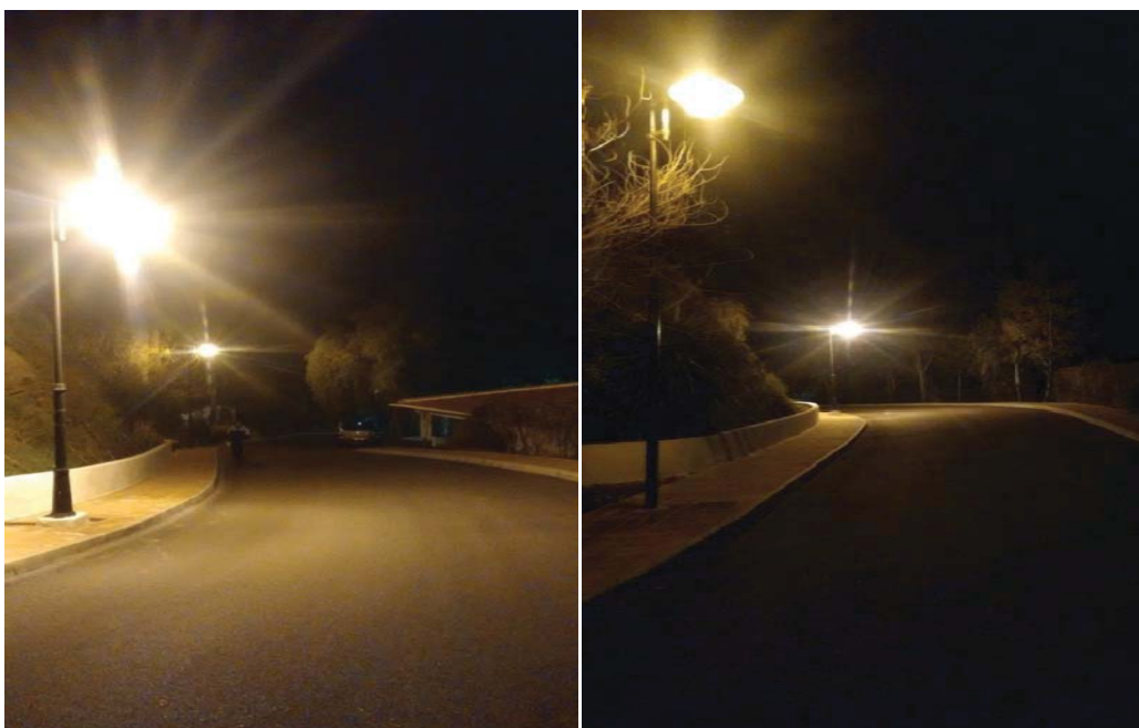
Calle la Estación
