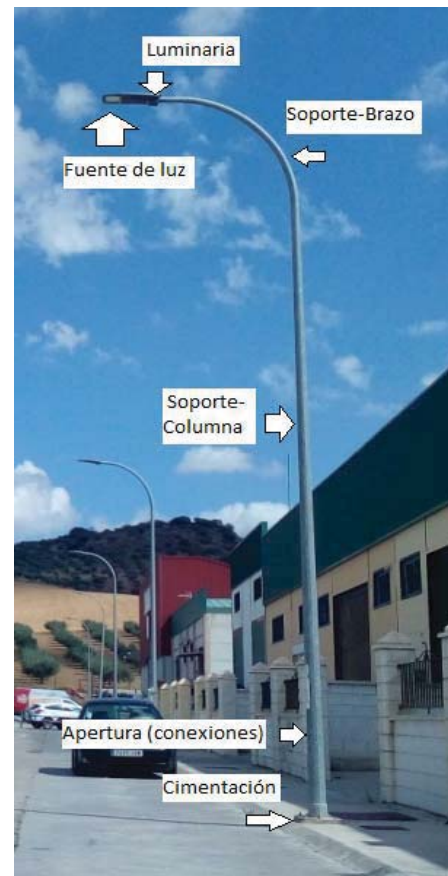
Figura 2.12. Elementos que conforman un punto de luz. Fuente: Elaboración propia.
