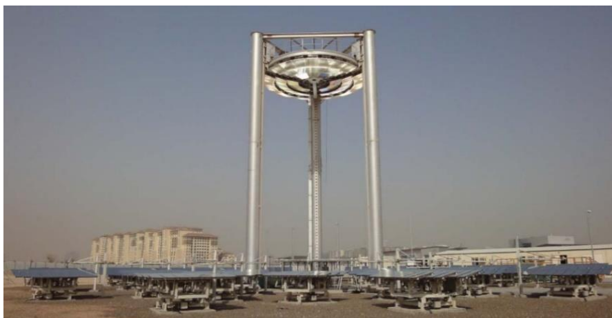
Figura 3.1: Sistema de concentração de torre solar com configuração Beam-Down em Masdar [28].
