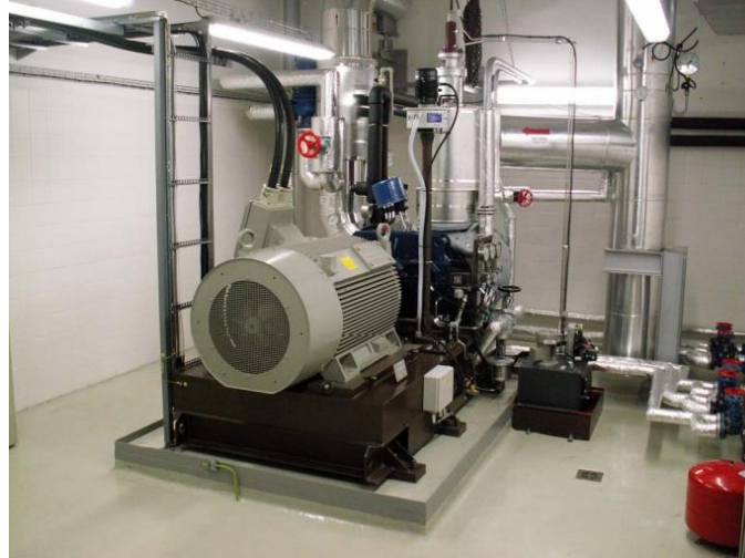
Figura D 1: Turbina de 700 kW para geração de eletricidade [41].
