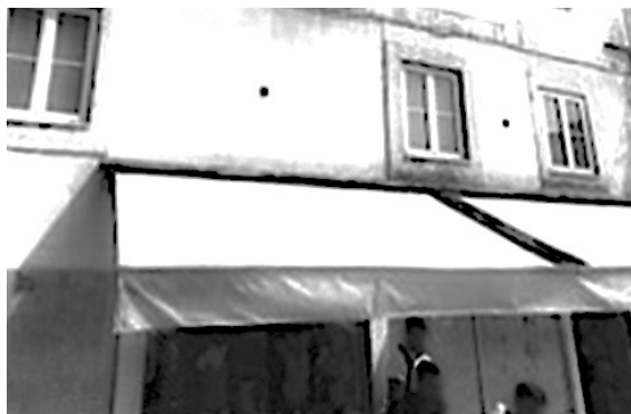
Fig. 2 Foto atual do prédio onde se encontrava o Bolero, no início da subida do Martim Moniz para a colina de Sant’Ana, pela Rua de São Lázaro (abaixo da pastelaria “A Caprichosa”)
