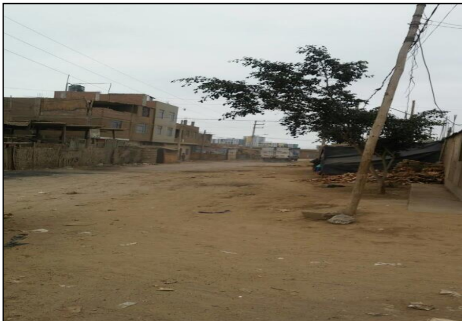
Imagen 4: calles en mal estado.
