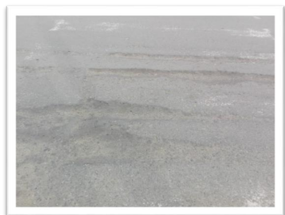
Figura 38. Ahuellamiento
