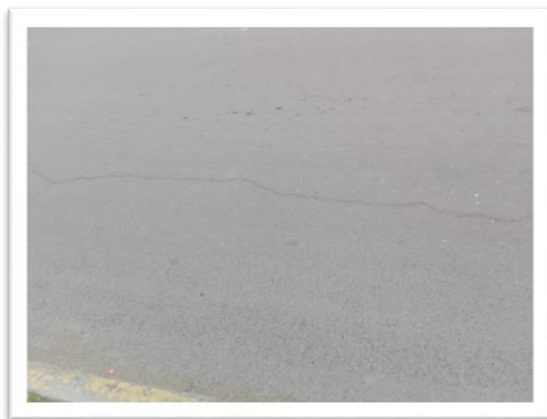
Figura 30. Grietas longitudinales
