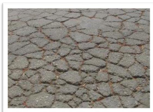
Figura 3. Piel de cocodrilo en pavimentos flexibles
