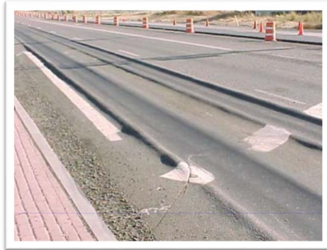
Figura 17. Ahuellamiento
