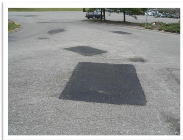
Figura 13. Parcheo en pavimentos
