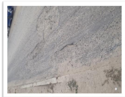
Figura 68. Ahuellamiento
