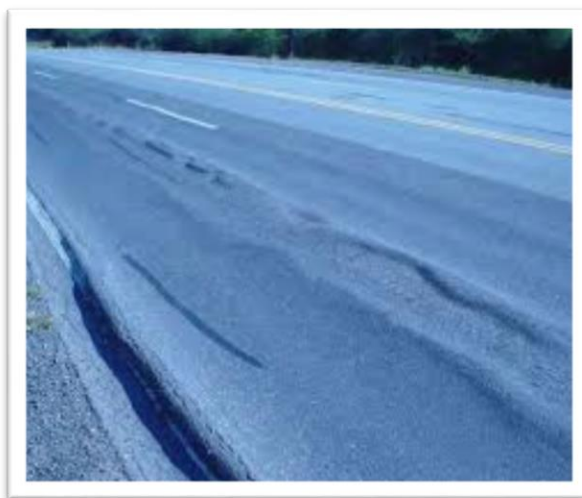
Figura 18. Desplazamiento
