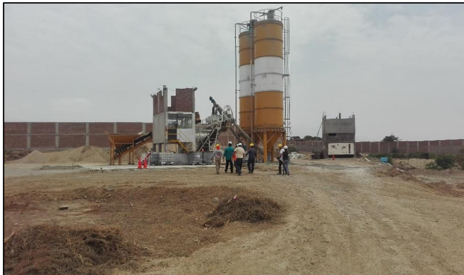
Figura 2.1 Planta de concreto premezclado KEN, Trujillo (Fuente: Propia)
