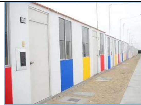
Módulos de vivienda social terminados
