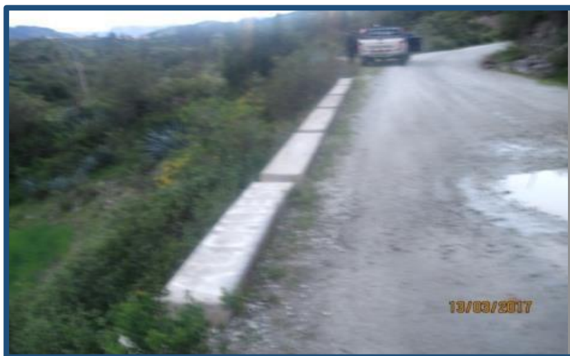
Imagen N°6: Tramo 04 Puente Pomachaca
