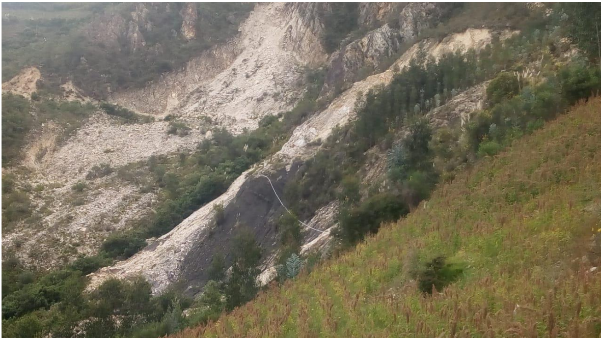
Vista panorámica de la Línea de Conducción desde el Manantial al Reservorio.
