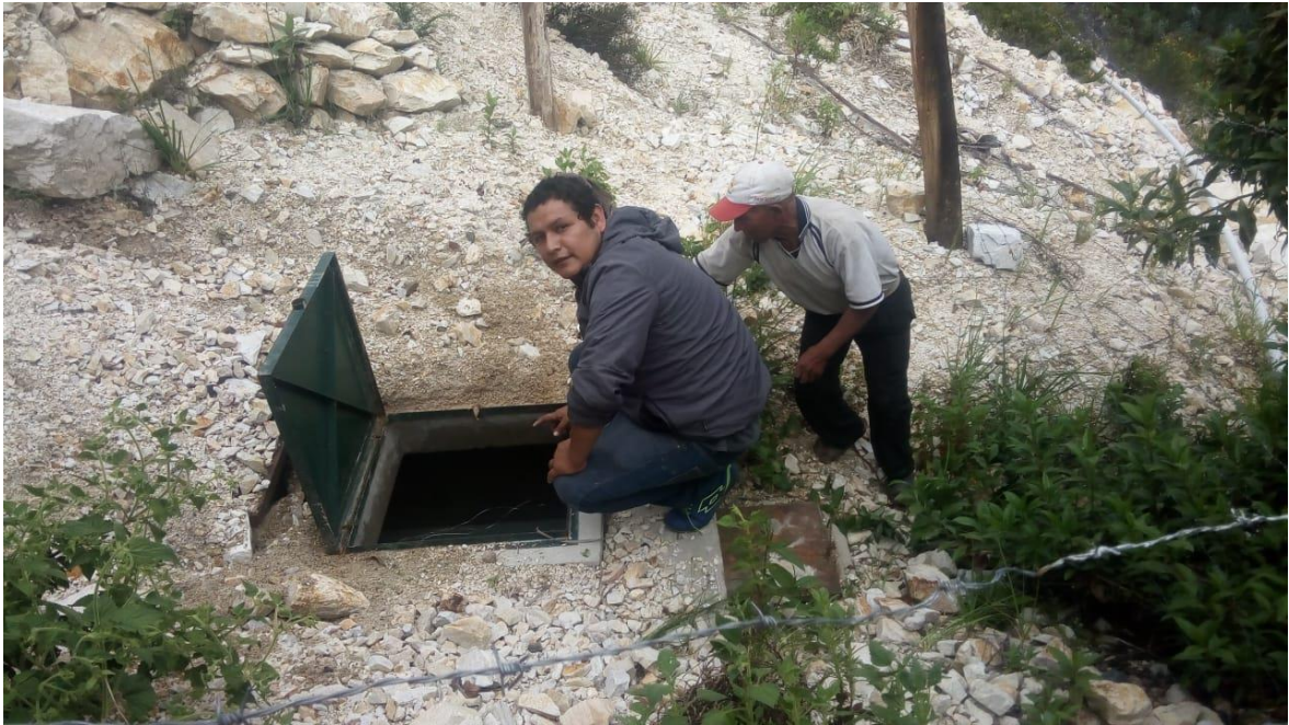
Manantial de Caserío de Coimaca en buen estado, solo necesita un pequeño mantenimiento y cambio de accesorios.
