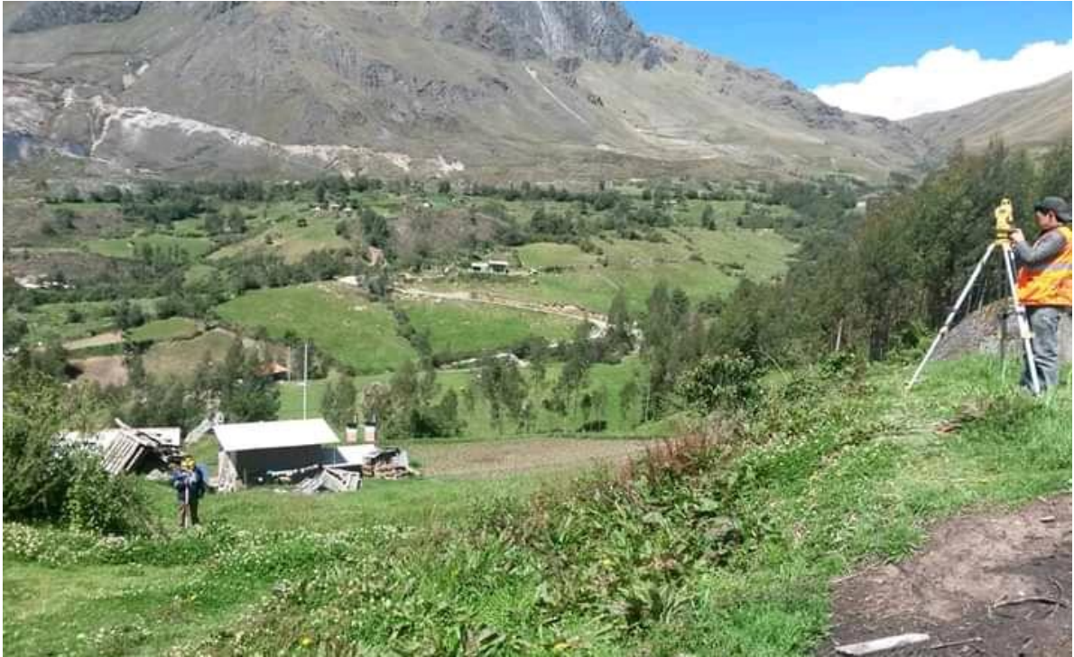
Levantamiento Topográfico con Estación Total.
