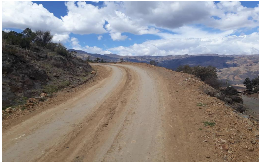
Figura 7. Tramo de la carretera de OTUZCO dirigiéndose a José Gálvez.
