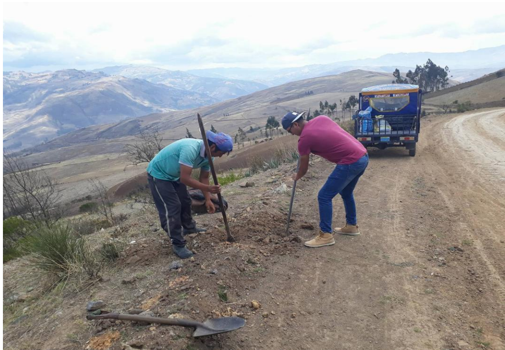
Figura 9. Excavación de las calicatas para obtener muestras del terreno
