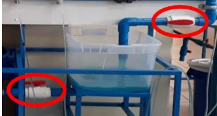
Figura N°40. Válvulas que Conectan al Tanque Graduado. P
