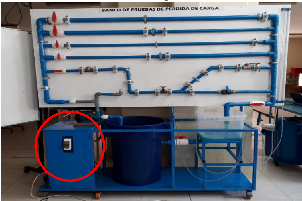
Figura N°34. Instalación Eléctrica de Empalme a la Bomba Fuente: Elaboración Propia.
