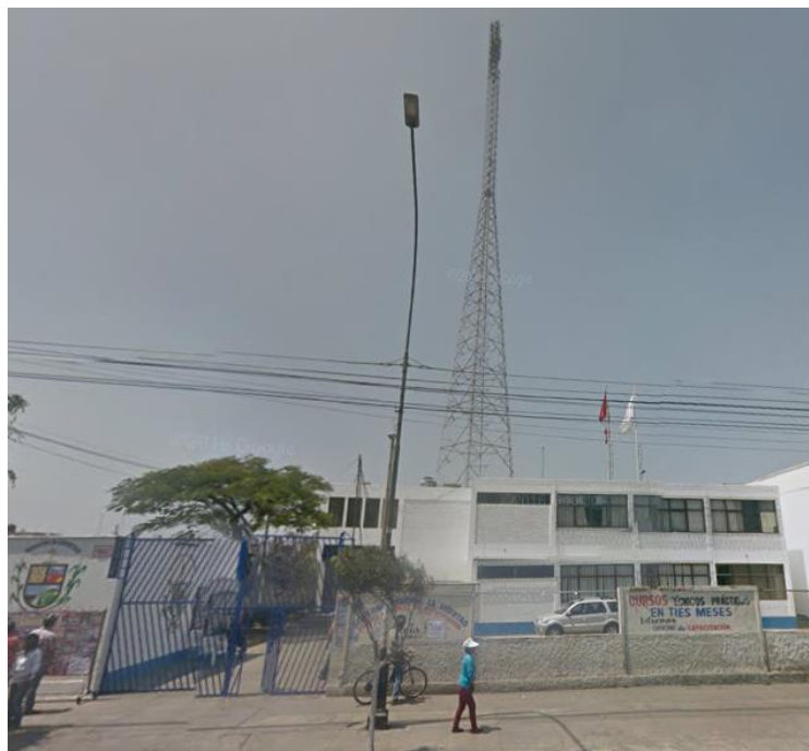
Figura N° 24 Ubicación del Transmisor Principal
