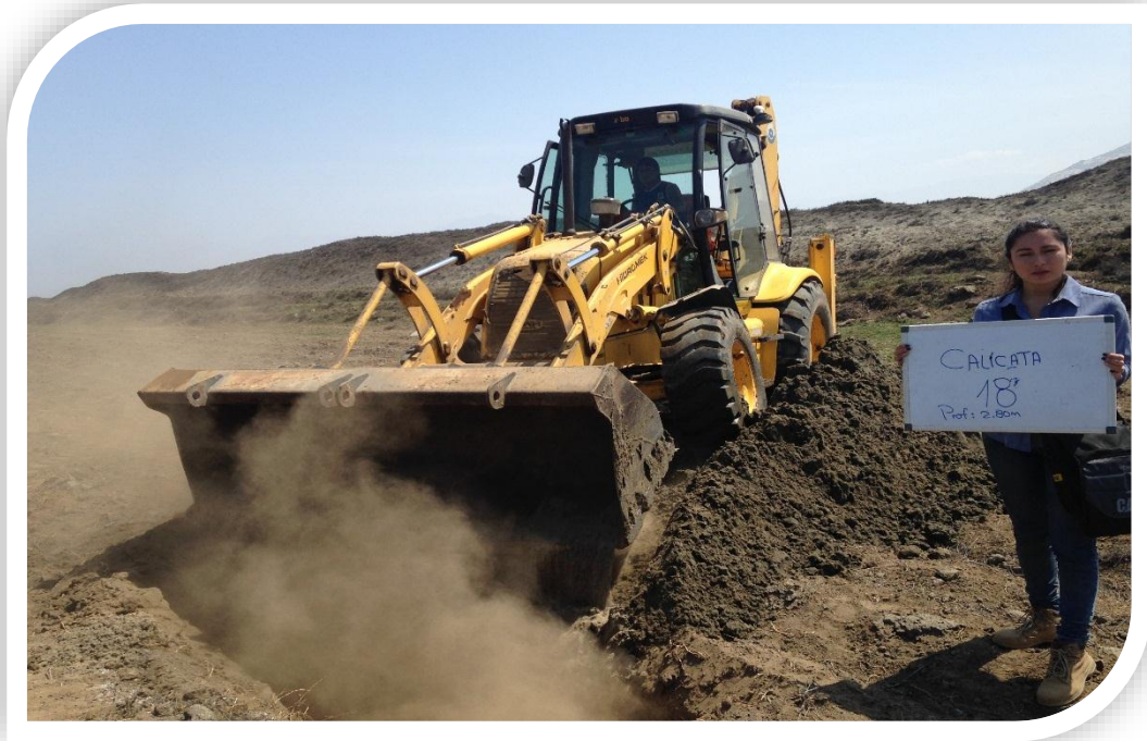
Anexo N° 09 – Excavación de calicata 18.
