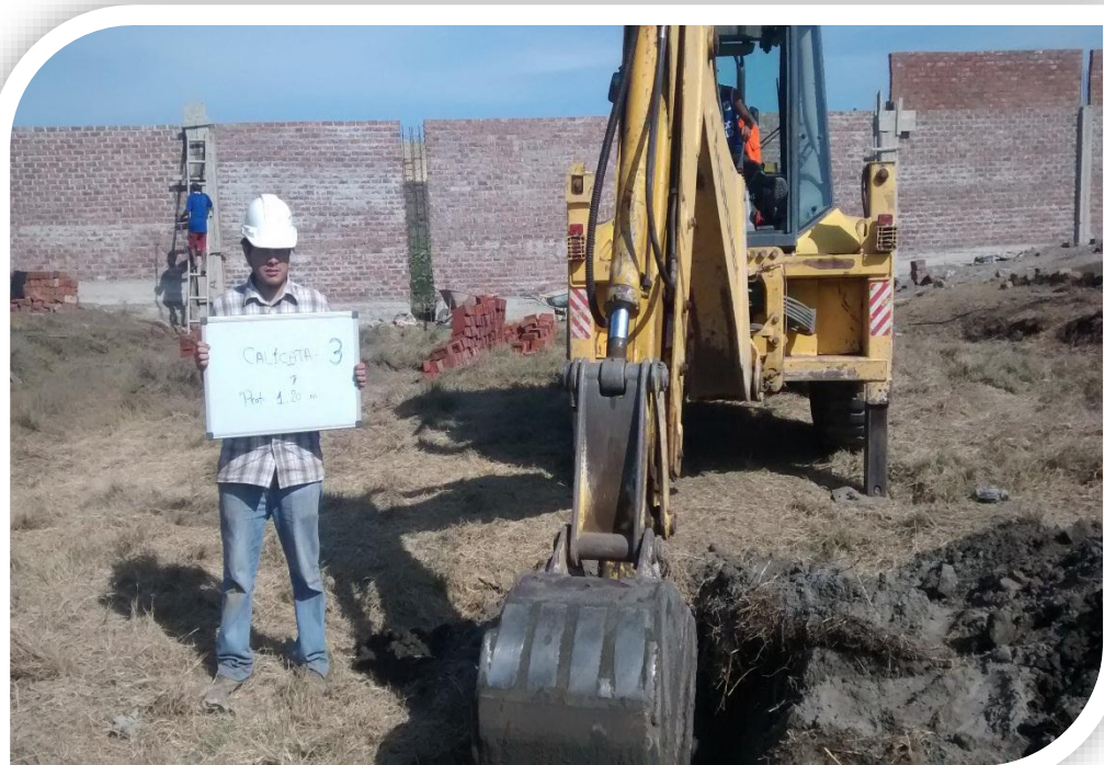
Anexo N° 06 – Excavación de calicata 03.
