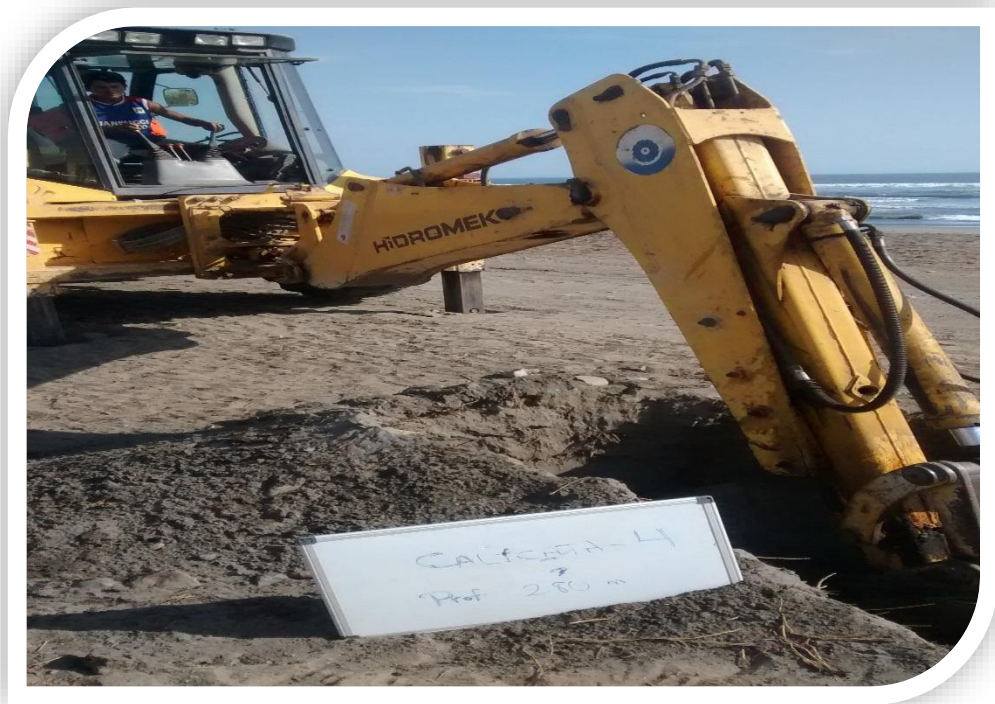
Anexo N° 07 – Excavación de calicata 04.
