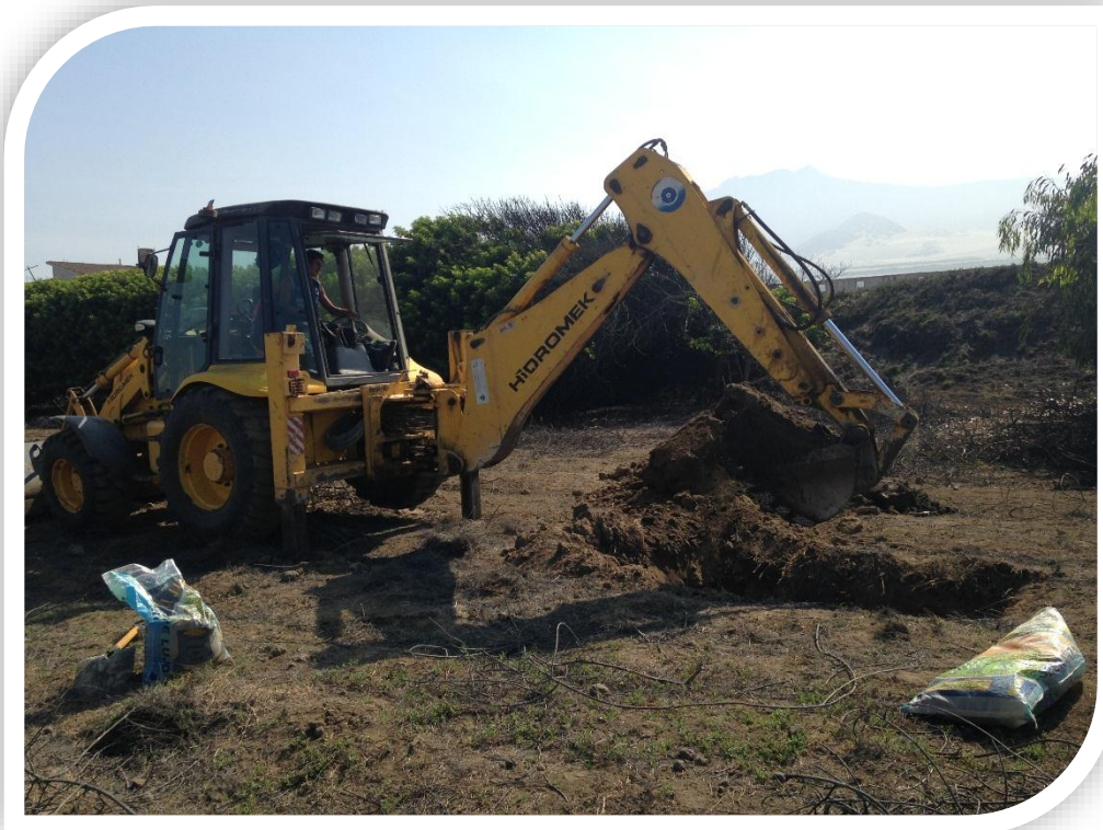
Anexo N° 05 – Excavación de calicata 01.
