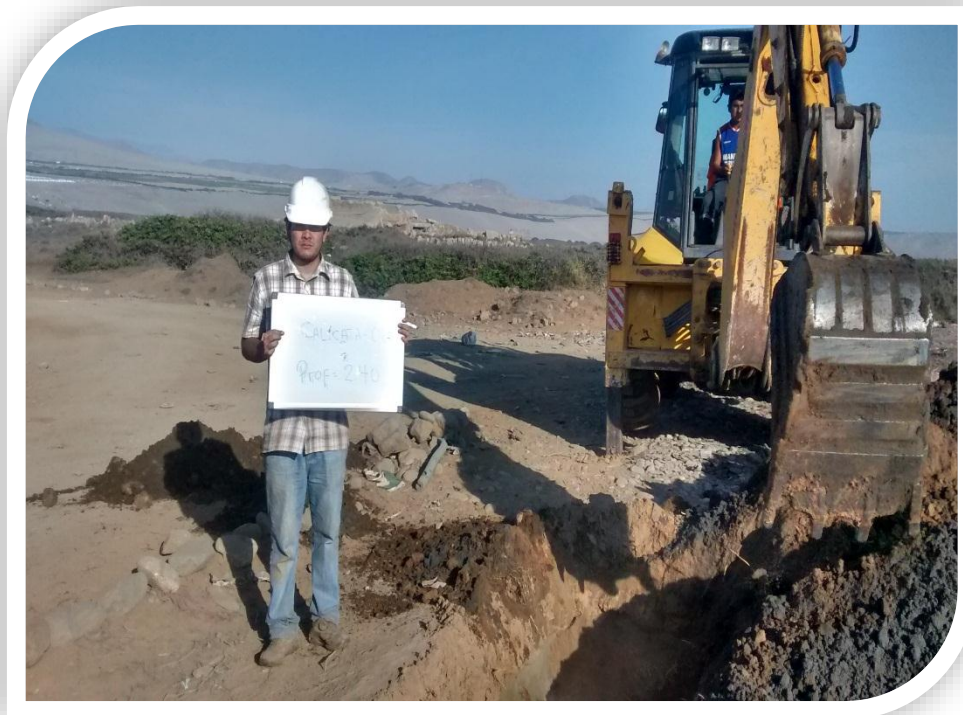
Anexo N° 08 – Excavación de calicata 08.
