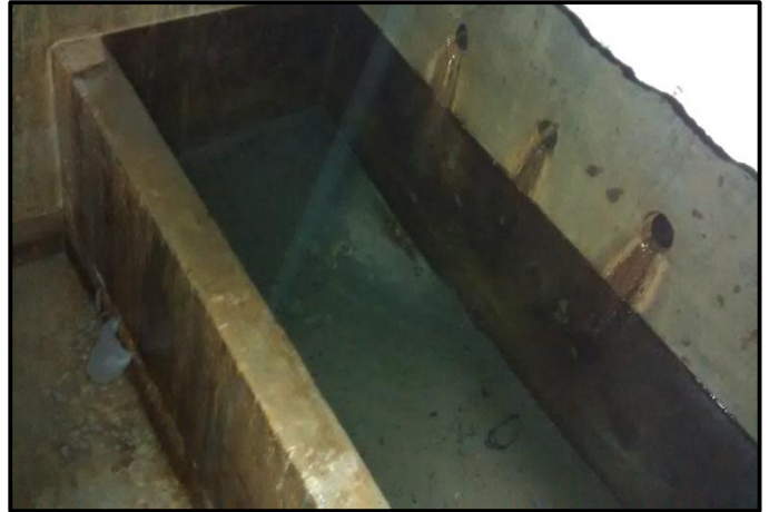
Anexo 2. Cámara Colectora Existente (Interior)
