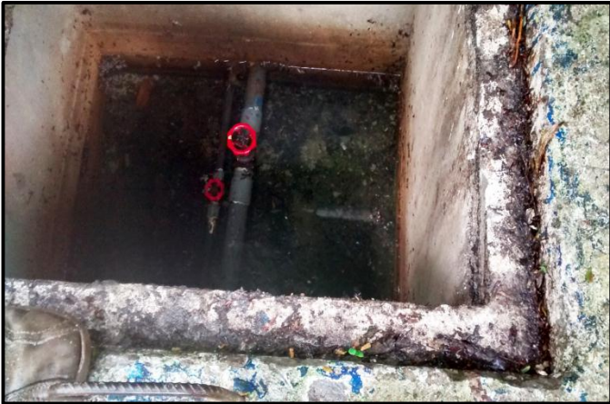
Anexo 3. Llaves de Cámara colectora
