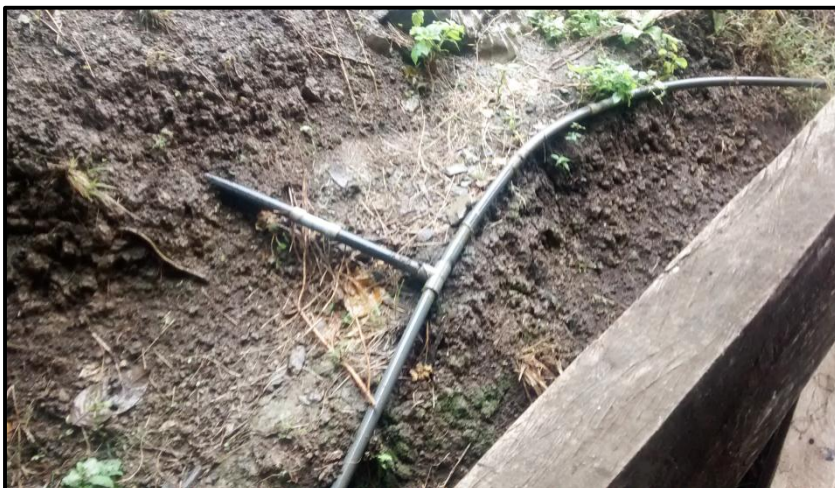
Figura 6. Tubería en la Superficie Terrestre
