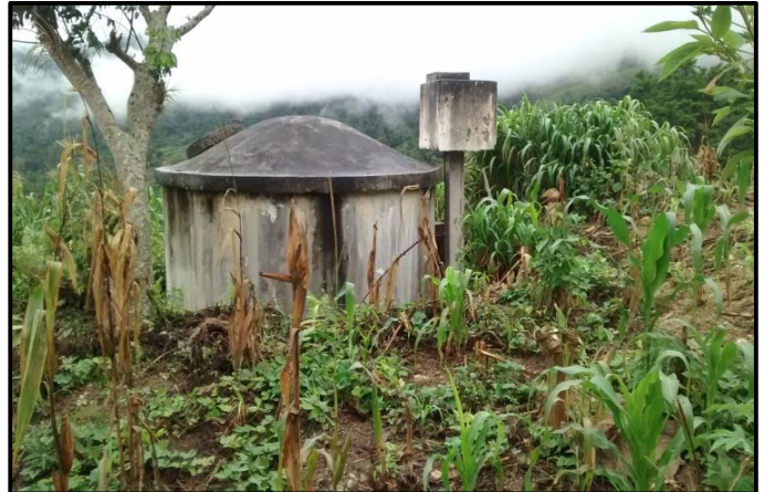
Anexo 4. Reservorio Existente
