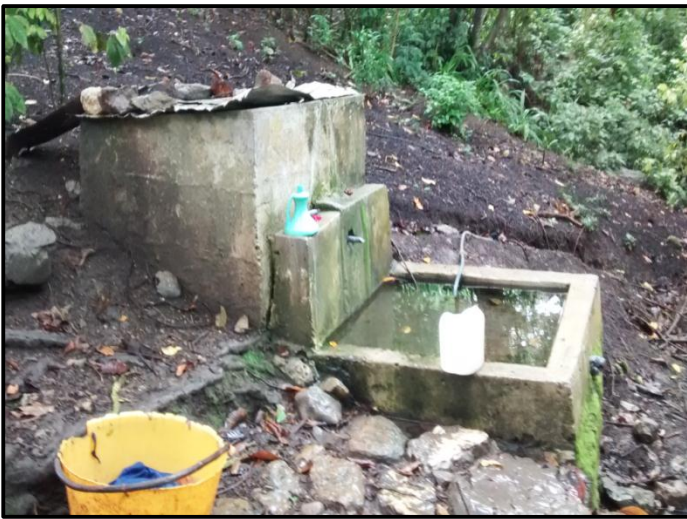
Anexo 9. Caños de las viviendas
