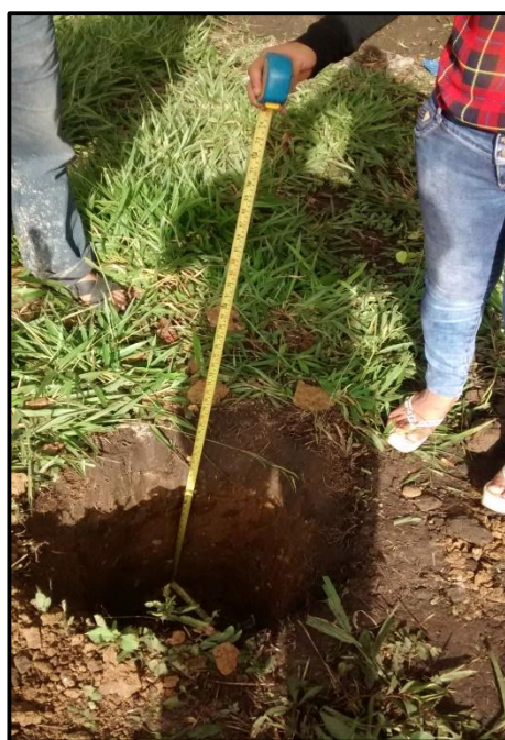
Figura 29. Calicata Terminada a 1.20 m
