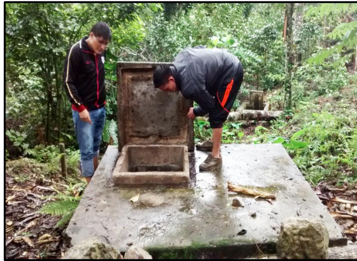
Figura 3. Exteriores de Cámara Colectora (Vista de Planta)
