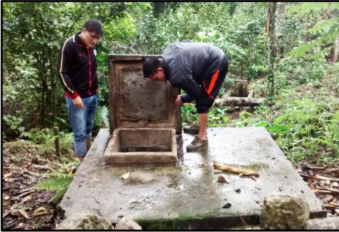
Anexo 1. Cámara colectora Existente (Exterior)
