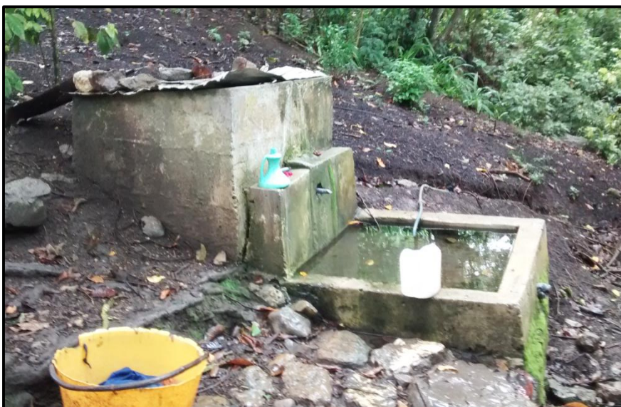
Figura 7. Caños y Almacenamiento de agua
