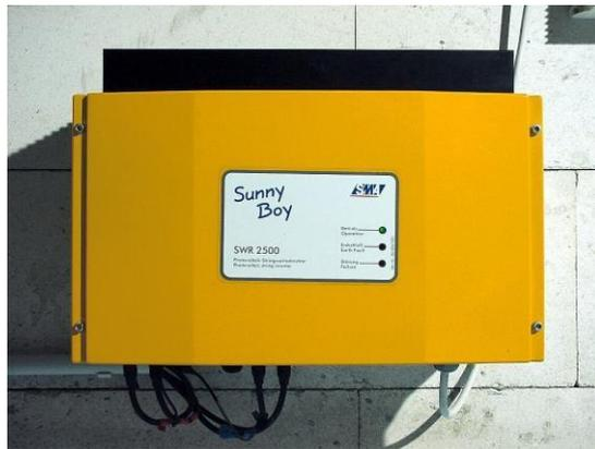
Fig. 2.14: Inversor de voltaje
