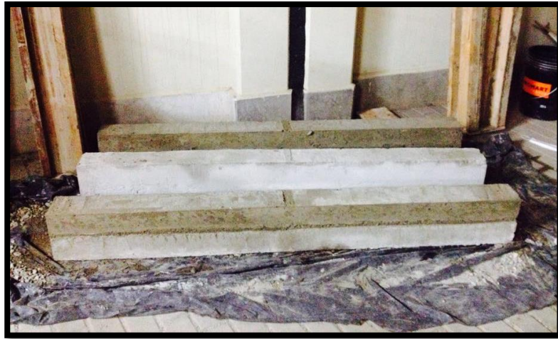
Figura 4.8.-Desencofrado de vigas
