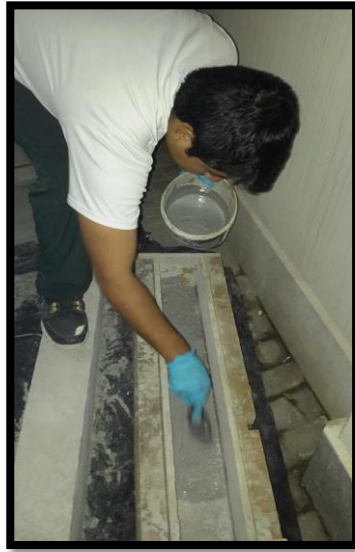
Figura 4.5. Aplicación de adhesivo epoxico
