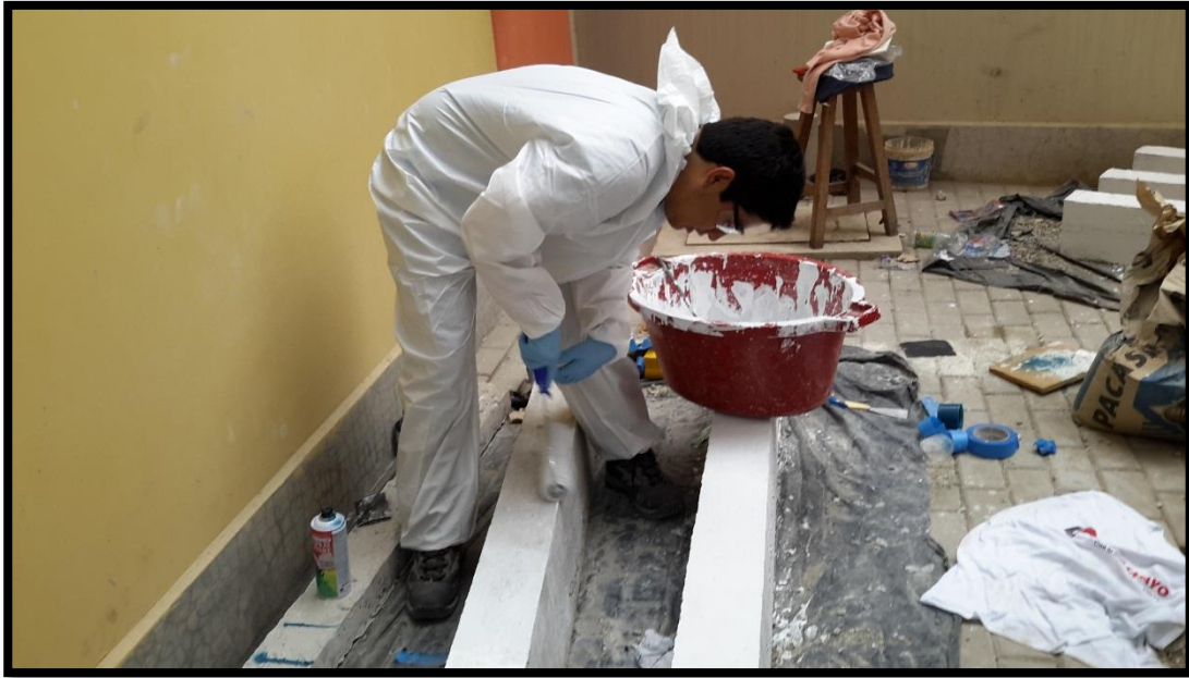
FOTOGRAFIA 7.- Aplicación de temple a vigas
