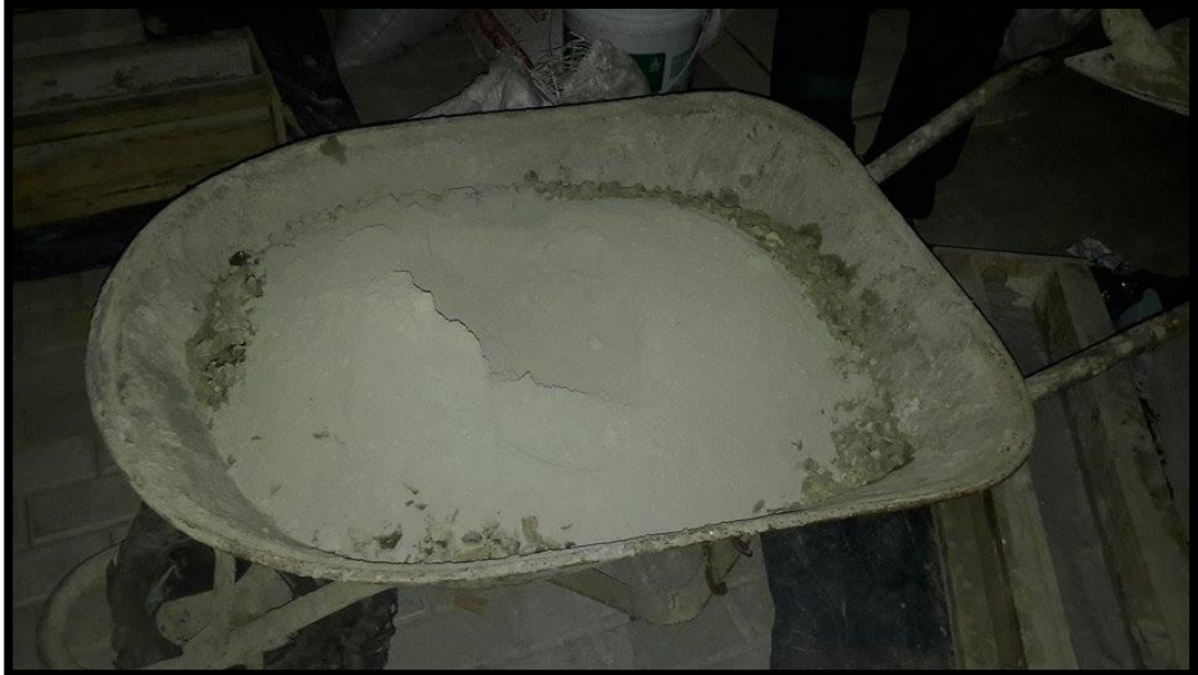
FOTOGRAFIA 2.- Cemento y gravilla
