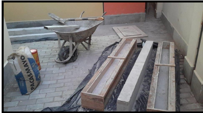
Figura 4.4. - Primera etapa del vaciado
