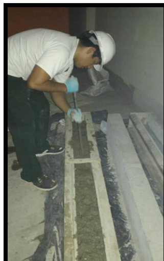
Figura 4.7. - Chuceo del concreto
