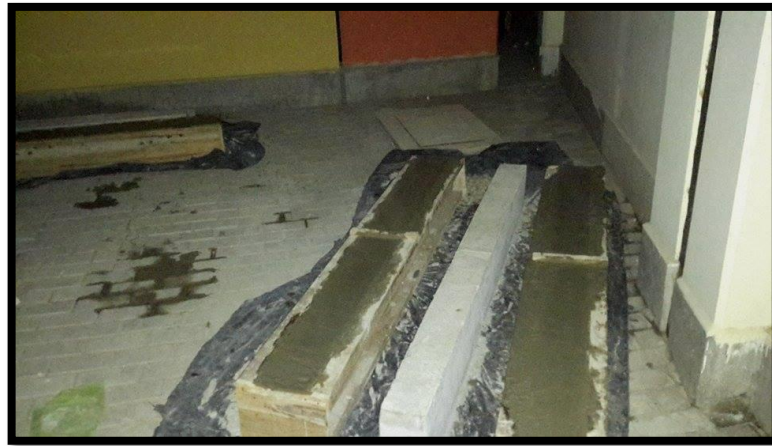
Figura 4.6. - Segunda etapa de vaciado
