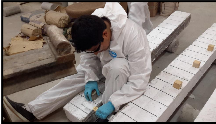
Figura 4.13.- Fijación de tacos de madera en cada viga
