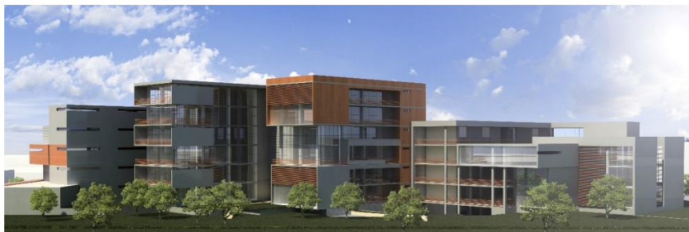
Figura N° 42: Vista de la elevación posterior la cual colinda con el Jardín Botánico
