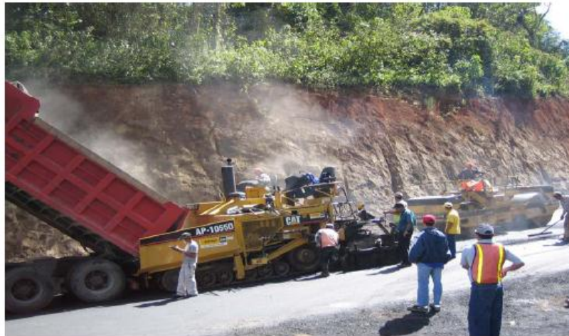
Figura 14. Aplicación de mezcla asfáltica modificada
