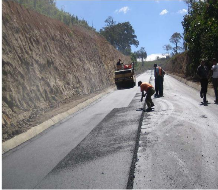
Figura N° 15 Compactado de la mezcla Asfáltica Modificada
