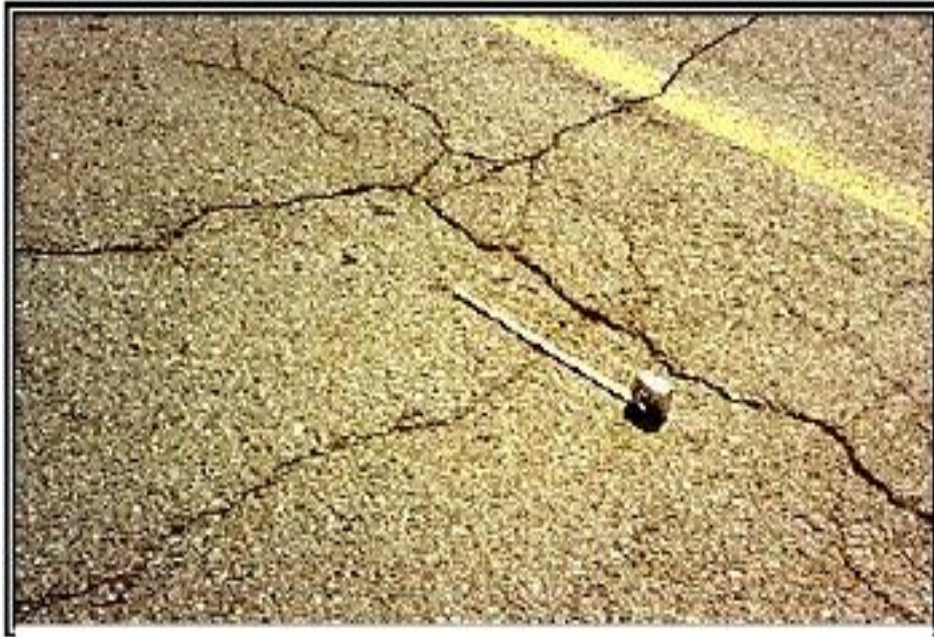
Figura N° 11 Rresentación de Calaveras en la Carpeta Asfaltica
