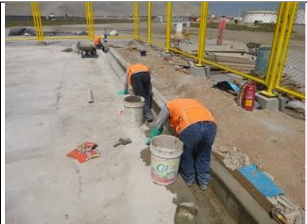
Solaqueado de estructuras de concreto (losa, buzón, canaleta, rampa y bases de cerco)
