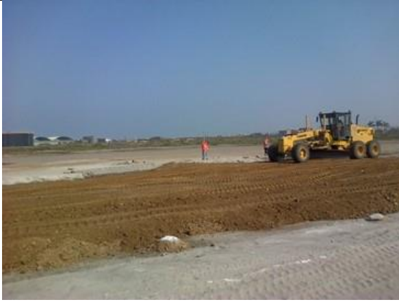
Movimiento de tierras: Traslado , colocado, nivelado y compactado de material afirmado
