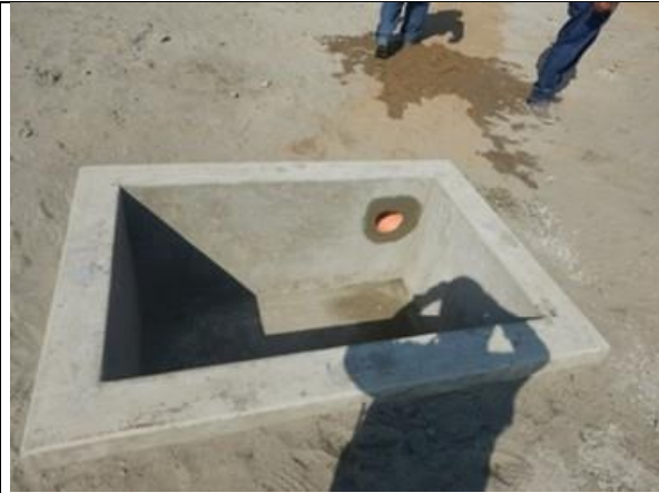
Colocado de buzón e instalación de tubería que une canaleta de losa con buzón
