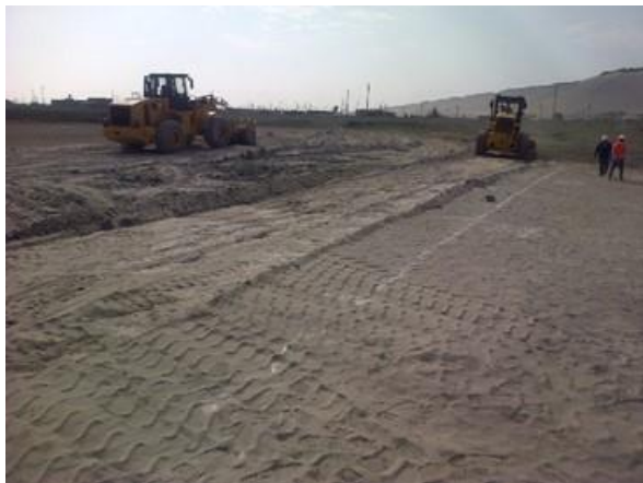
Movimiento de tierras: Corte de terreno, nivelación y compactación
