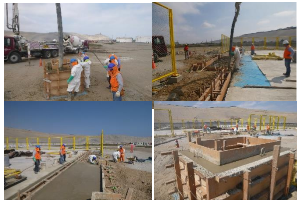
Vaciado de concreto de buzón de drenaje, canaleta y rampa de acceso.
