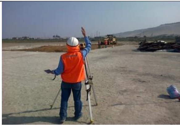
Verificación de niveles de capa de afirmado y ensayos de densidad de campo
