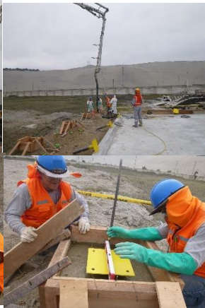
Vaciado de concreto de bases de cerco, colocado y nivelado de poyos
