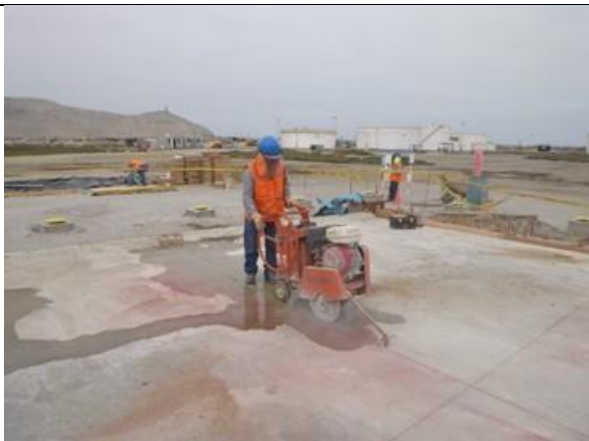
Corte de pavimento y colocado de juntas
