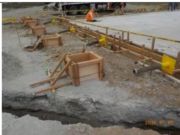
Encofrado bases para cerco y puerta (39 bases)
