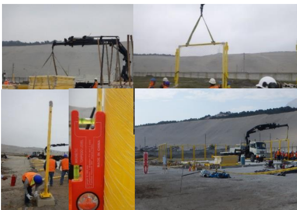
Montaje de cerco metálico y puerta.
