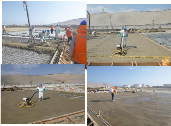
Vaciado de concreto de losa (2 paños)
