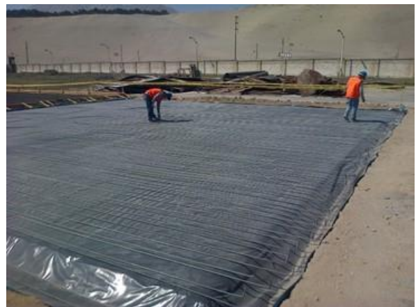
Excavación de zanjas para uñas de losa y colocado de manta (polímero de 4 mm)
