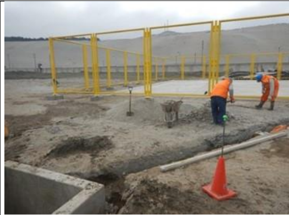
Colocado de buzón e instalación de tubería que une canaleta de losa con buzón
