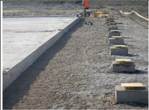
Vaciado de concreto de bases de cerco, colocado y nivelado de poyos
