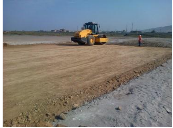
Movimiento de tierras: Traslado , colocado, nivelado y compactado de material afirmado
