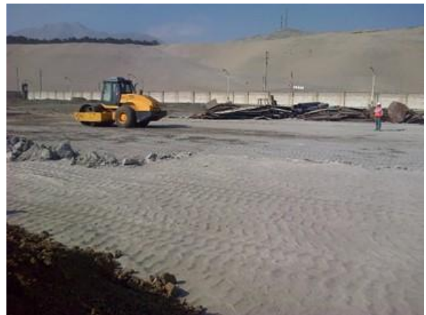
Movimiento de tierras: Corte de terreno, nivelación y compactación
