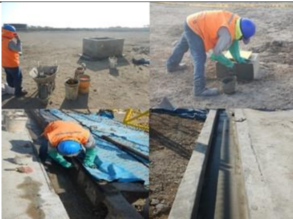
Solaqueado de estructuras de concreto (losa, buzón, canaleta, rampa y bases de cerco)
