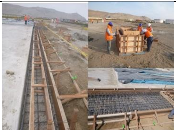
Encofrado: Losa (2 paños), canaleta buzón y rampa de acceso
