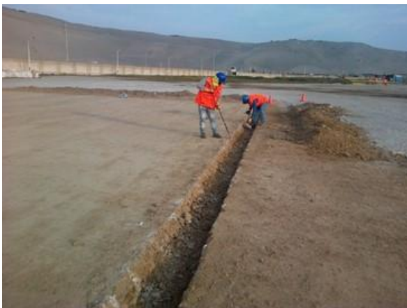
Excavación de zanjas para uñas de losa y colocado de manta (polímero de 4 mm)
