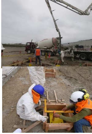
Vaciado de concreto de bases de cerco, colocado y nivelado de poyos
