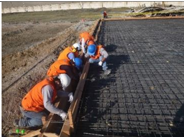
Encofrado: Losa (2 paños), canaleta buzón y rampa de acceso
