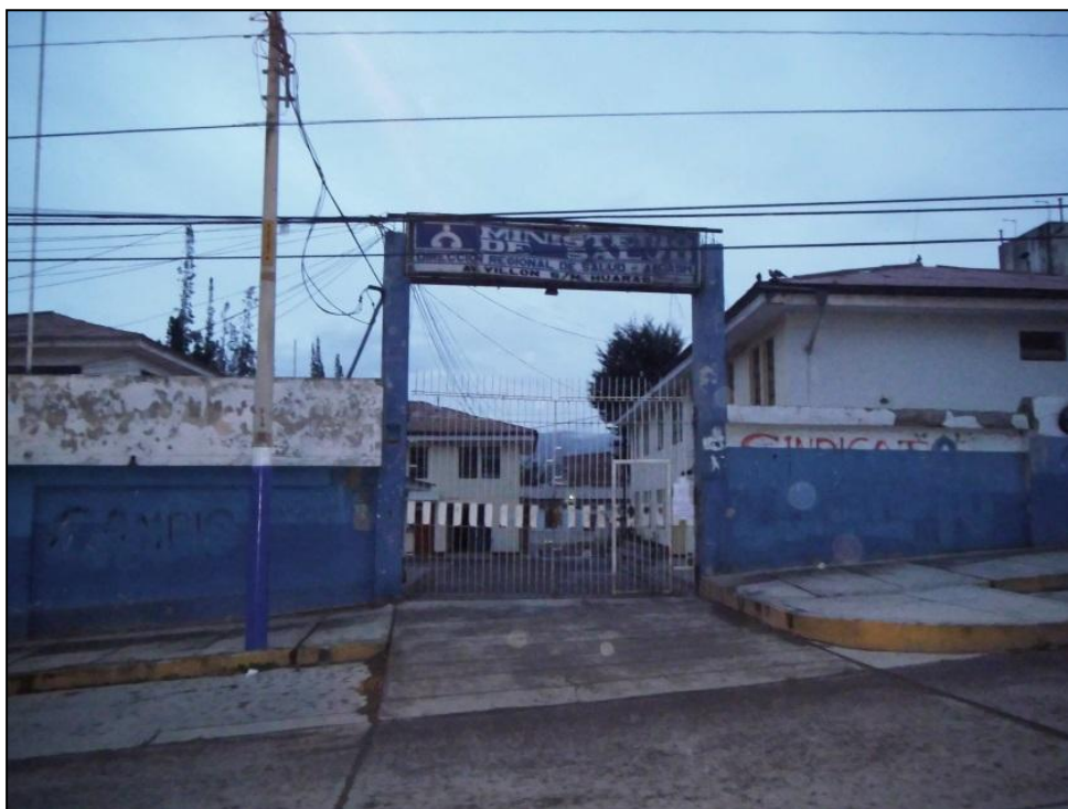
Ilustración 1-4: Ingreso A La Unidad De Emergencia Del Hospital Víctor Ramos Guardia - Av. Pedro Villón
