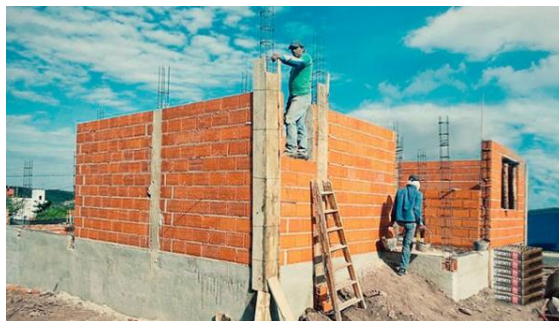
Figura 21. Construcción de muros de albañilería confinada
