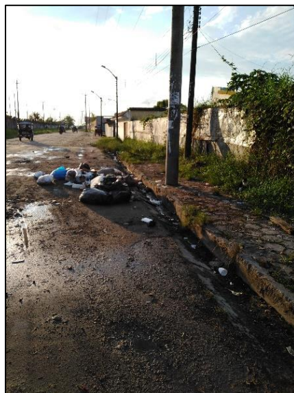
Figura 12: basura acumulada cerca a la cuneta
