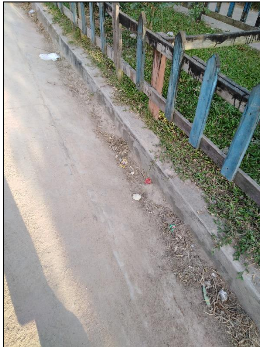
Figura 6: cuneta al borde de la pista
