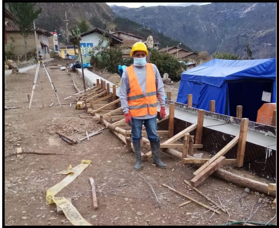
Fotografía 7: Vista principal Calle San Nicolás, cuadra 2 (En construcción). Fuente: Propia.
