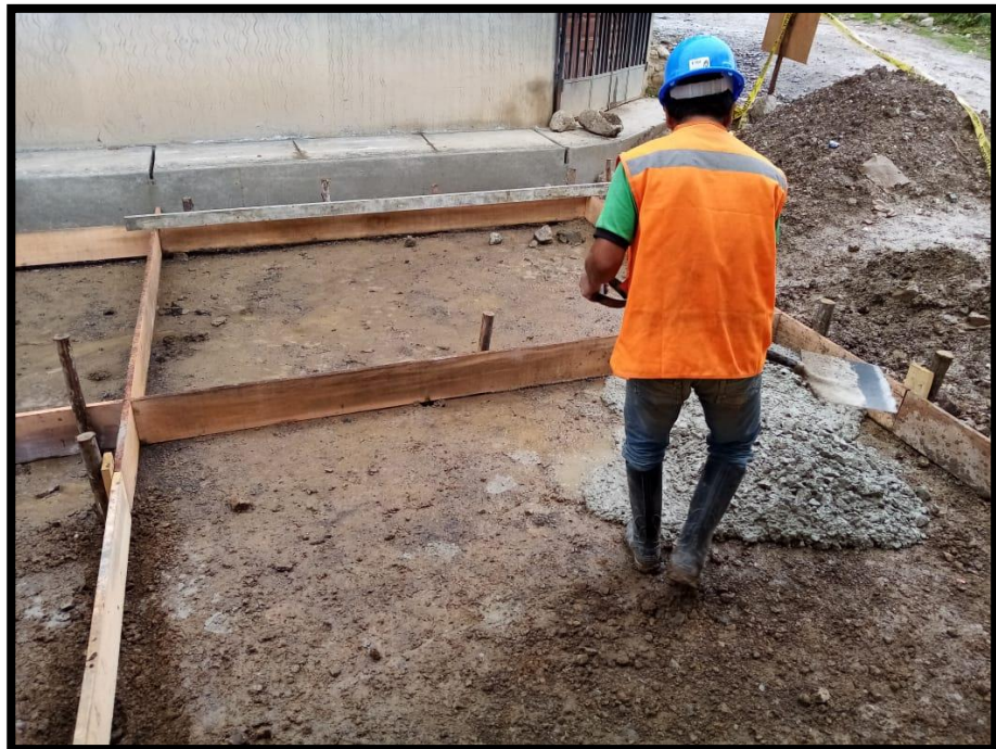
Fotografía 6: Vista principal Calle San Nicolás, cuadra 2 (En construcción). Fuente: Propia.
