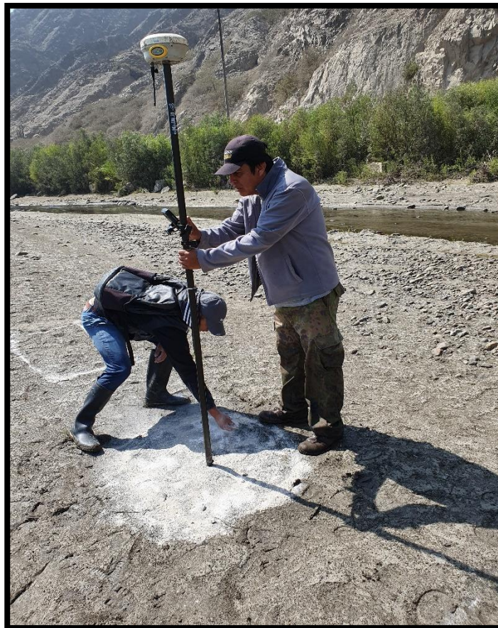
Ilustración 67: Recolección de coordenadas de puntos de control
