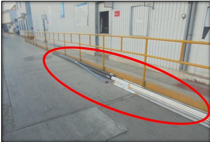
Figura 39. Malas prácticas de almacenamiento varillas
