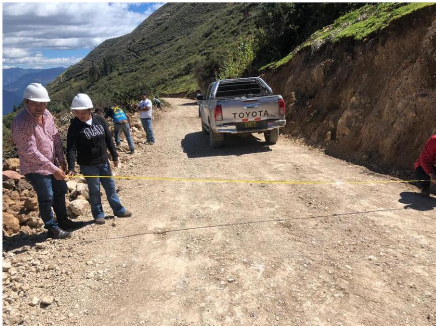
**Fotografía N° 10 : Vista de Tesista en trabajos de topografía y mediciones ancho de la carretera Tayabamba – Ongon.**
