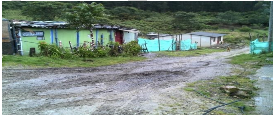
Figura 3 Estado en la vía barrio Aguas Claras
