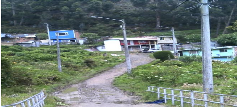
Figura 4 Estado en la vía del Barrio Entre Nubes
