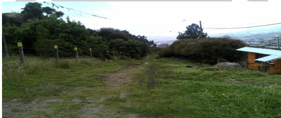
Figura 5 Estado en la vía del barrio Juan Rey
