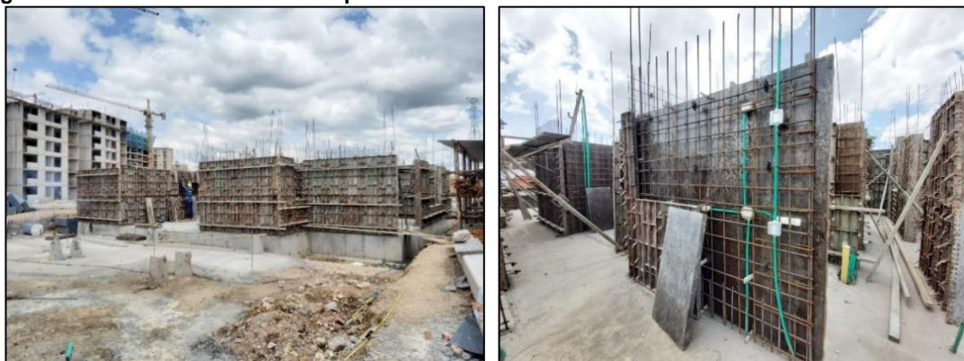
Figura 15 Estado Muros corte 21 sept 2020
