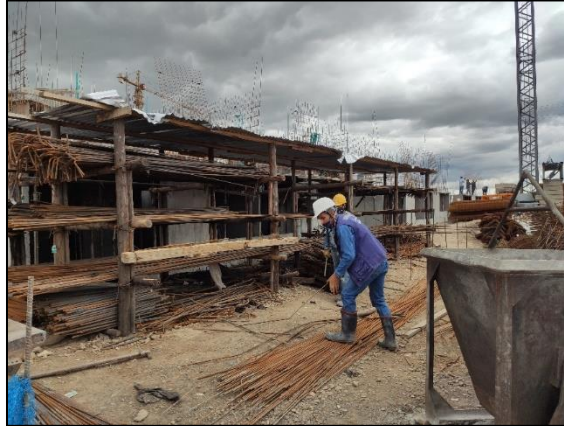
Figura 22 Traslado de burros de acero para mejor acceso al material
