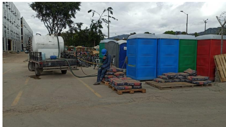
Figura 23. Limpieza de baños.
