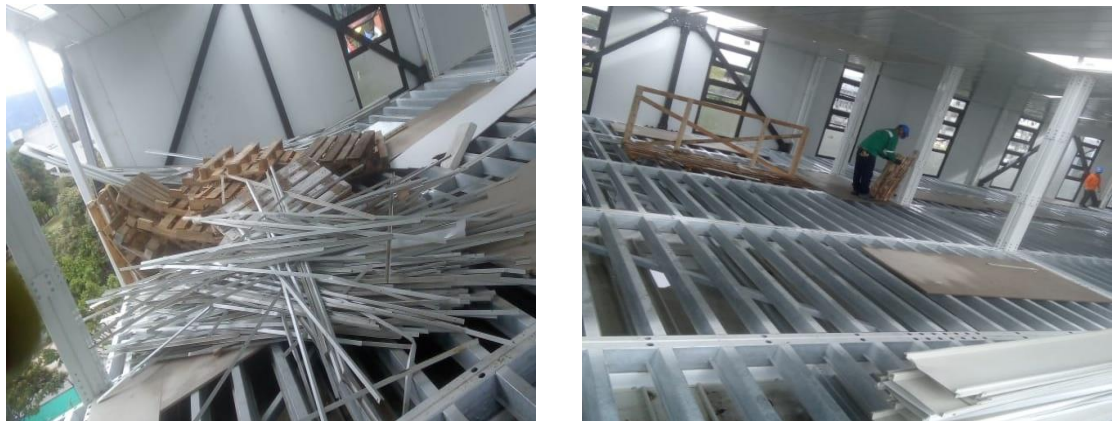
Figura 22. Limpieza de zonas de trabajo
