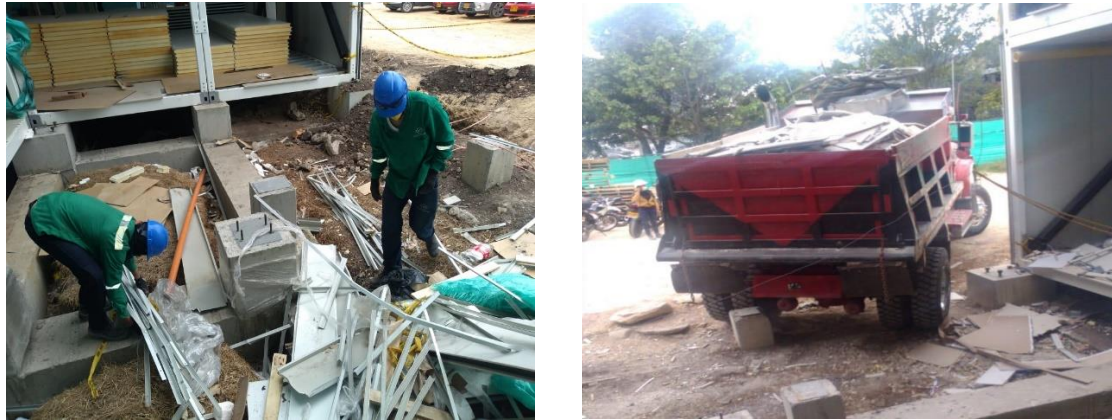
Figura 24. Retiro de sobrantes
