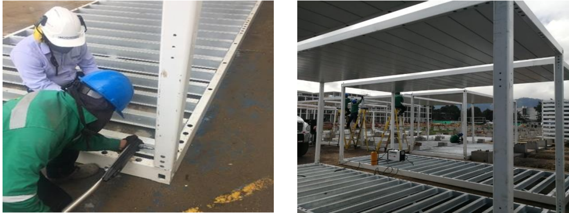
Figura 28. Armado de módulos.
