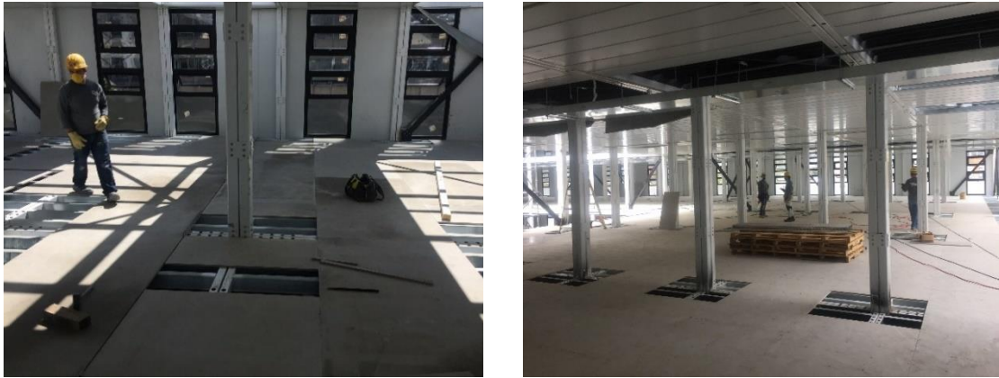
Figura 36. Instalación de Fibrocemento.
